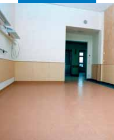
Пример укладки ПВХ в рулонах в больнице Св. Джозефа в Германии
