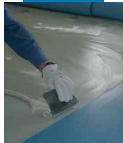
Нанесение клея Ultrabond Eco V4 SP в пансионате Сан Мартино в Италии
