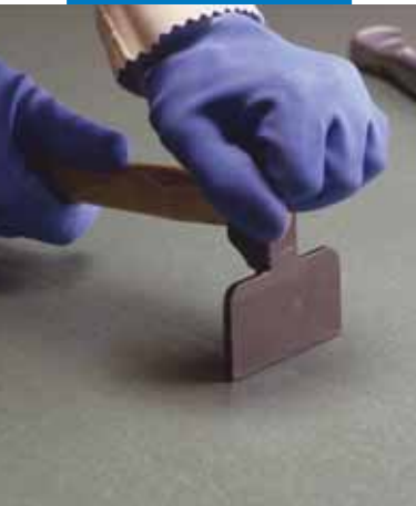
Разглаживание стыков между рулонами покрытия
